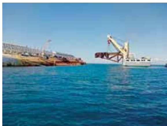
Ecco alcune spettacolari immagini della posa dell'impalcatura nata a Piacenza nei suoi componenti e servita a realizzare il piano su cui appoggiare il relitto una volta raddrizzato
