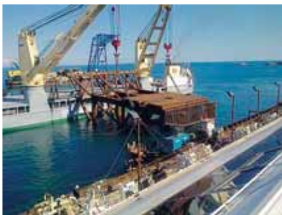
Ecco alcune spettacolari immagini della posa dell'impalcatura nata a Piacenza nei suoi componenti e servita a realizzare il piano su cui appoggiare il relitto una volta raddrizzato
